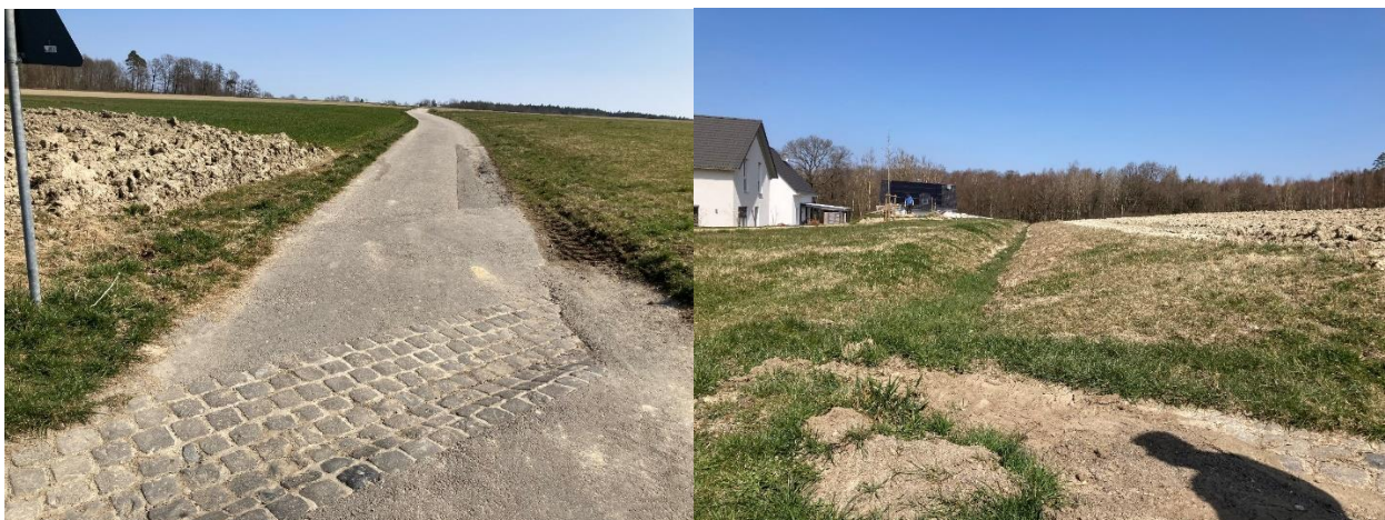
Abb. 4-41: Querrinne südlich des Neubaugebietes kann eingetieft und/oder verbreitert werden (links), Graben vor Grundstücken „Am Scheid“ sollte auf den ersten 20m vertieft und regelmäßig gepflegt werden
