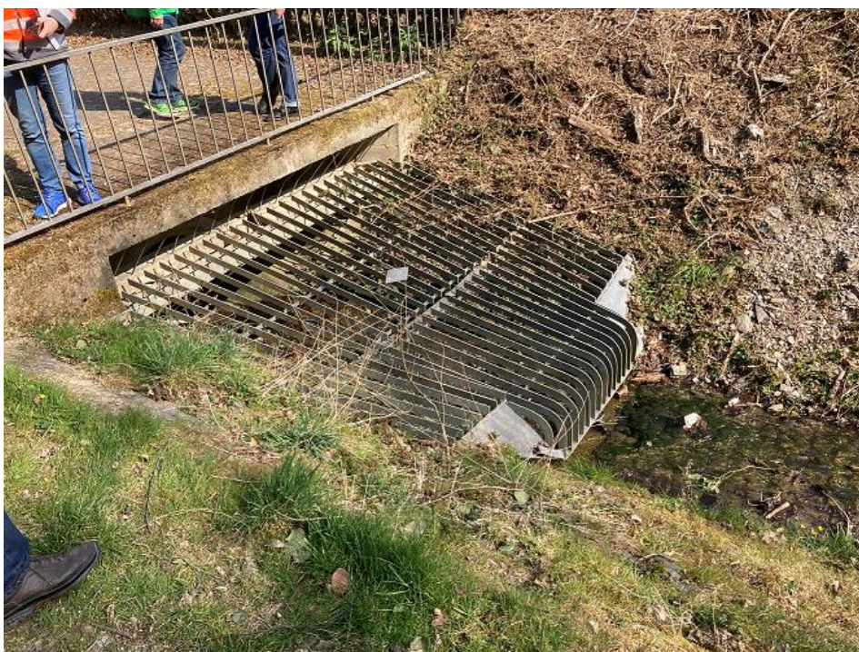
Abb. 4-50: Einlaufbauwerk des Heimbaches in den Rhein
