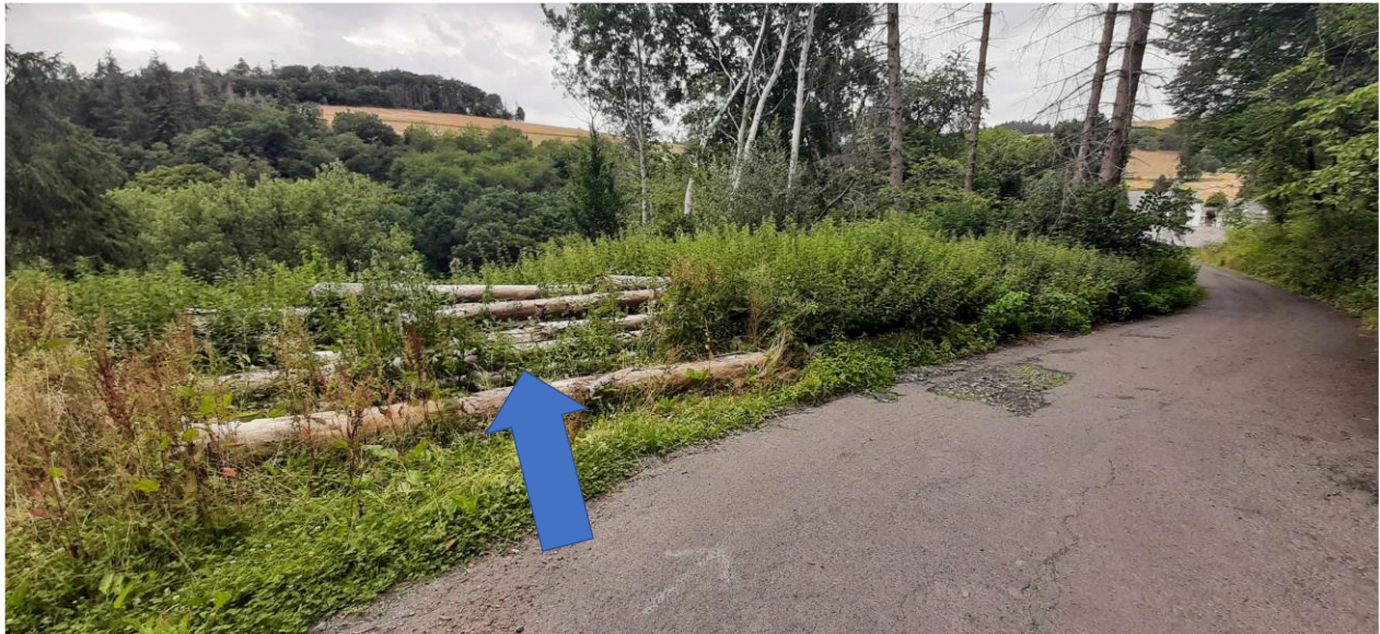
Abb. 4-17: Schaffen von Notwasserweg am südlichen Hang
