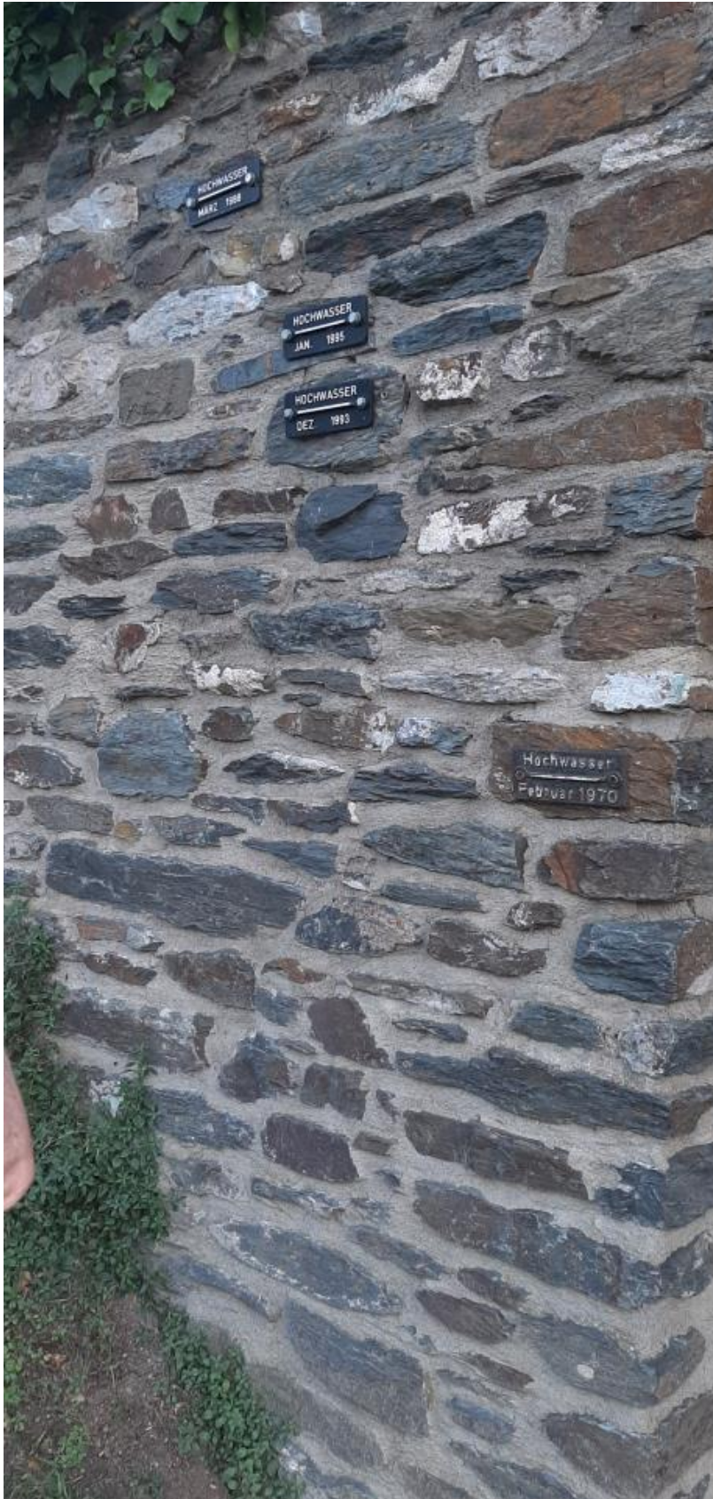
Abb. 4-107: Beispiel Hochwassermarken Oberwesel
