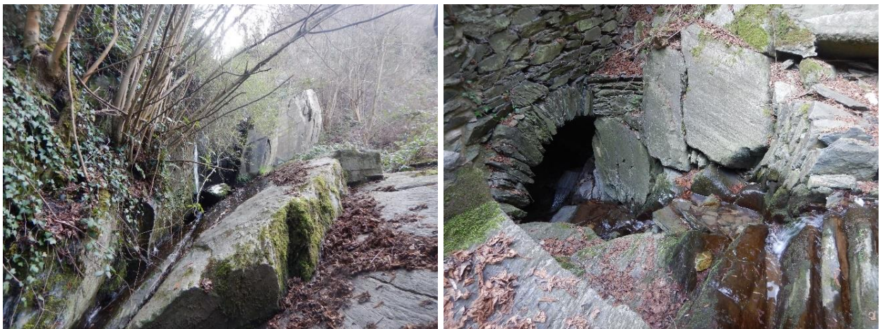
Abb. 4-63: Lohbach kurz vor Beginn der Verrohrung
