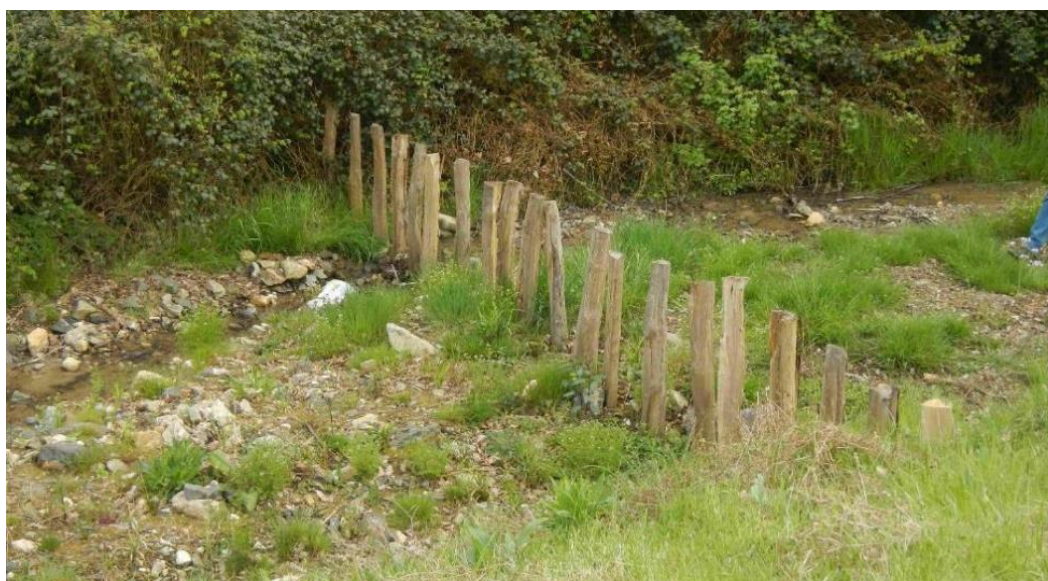
Abb. 4-1: Pfahlreihen zum Treibgutrückhalt im Vorfeld einer Verrohrung
