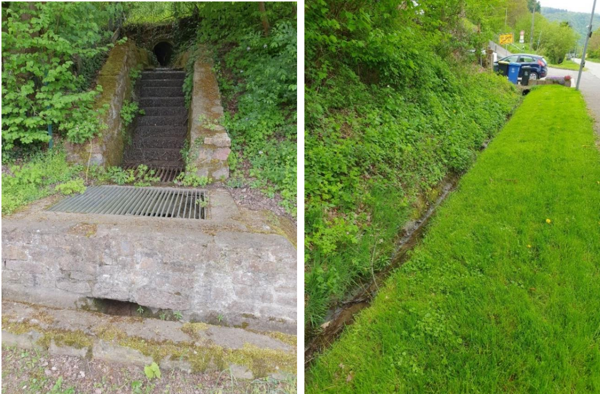
Abb. 4-55: Einlaufbauwerk des Schlittenbachs (links); seitliche Ableitung durch Straßenseitengraben
